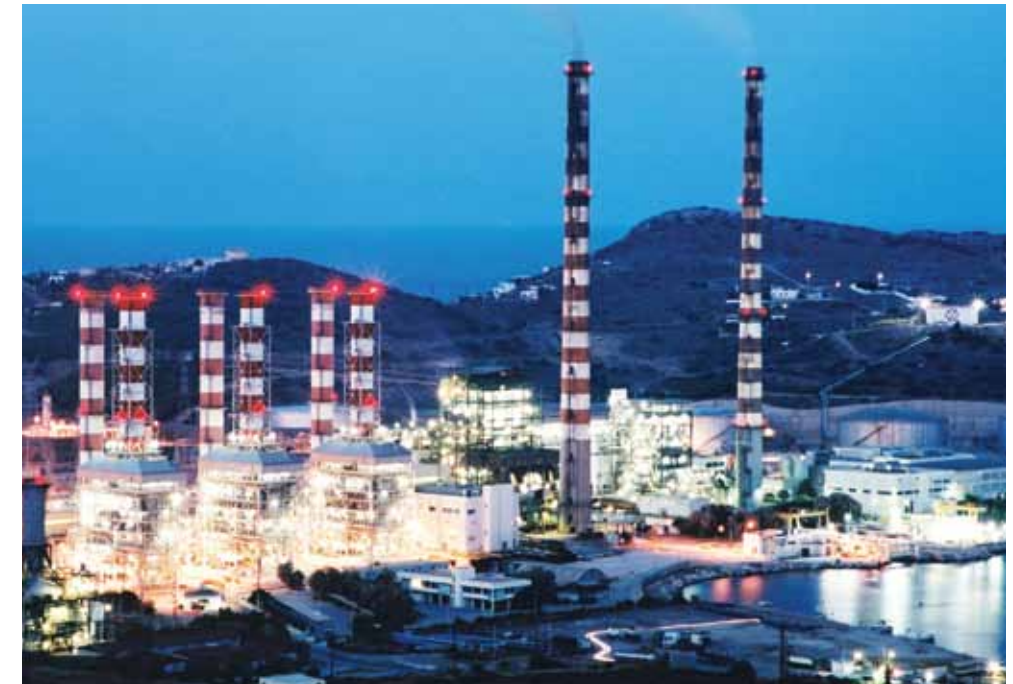
ΔΕΗ Μονάδα Παραγωγής Ηλεκτρικής Ενέργειας (Λαύριο Αττικής)
