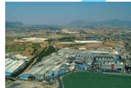
Αεροφωτογραφία των εγκαταστάσεων της ΕΛΒΑΛ Οινόφυτα Βοιωτίας
