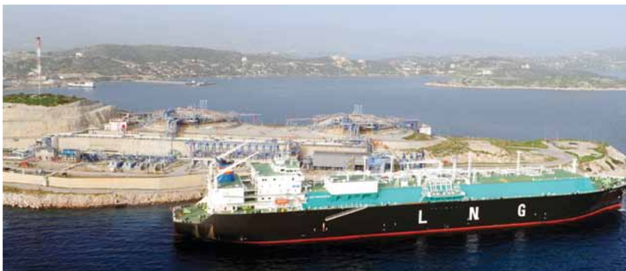
Πλοίο LNG στη Ρεβυθούσα
